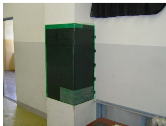
補強工事の講習(2)
