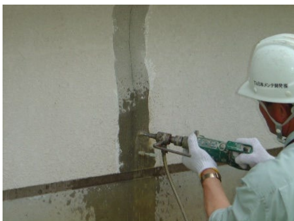
補強工事の講習(1)
