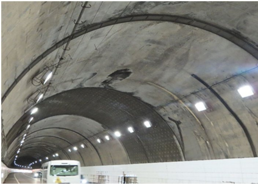
写真－2.5.4.1 1980年代の覆工例（補修・補強）
