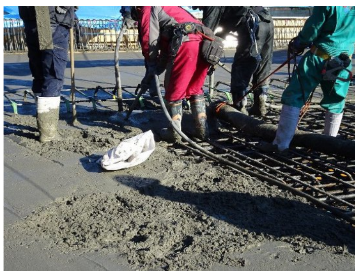
写真-2.5.3.1 RC床版の施工
