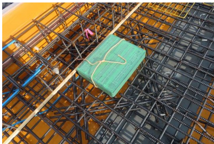
写真-2.5.3.5 RC床版の排水柵
