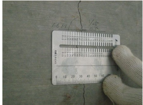
写真-2.2.1.7 外部拘束による温度ひび割れ
