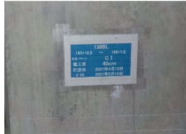
・【良好な事例】支保パターン変化スパンに覆工厚・打設日を示した表記がある。
