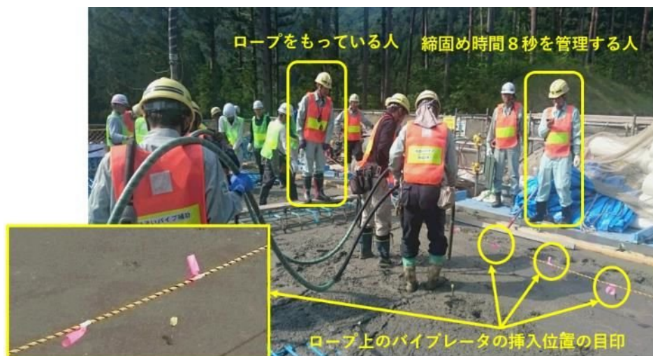
写真-2.4.1.18 RC床版用の施工状況把握チェックシートを用いた品質確保に配慮した施工事例
