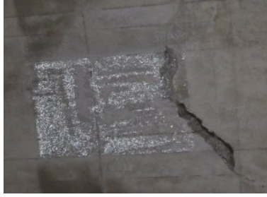
・天端部の補修跡。多くのスパンで実施されている。 ・天端吹き上げ口周辺にコールドジョイント。
