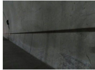
・【良好事例】SLより下部にビニールシート養生の跡がある。
