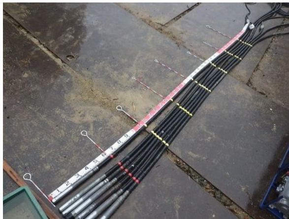
写真-2.5.2.29 下層への10cm挿入を可視化
