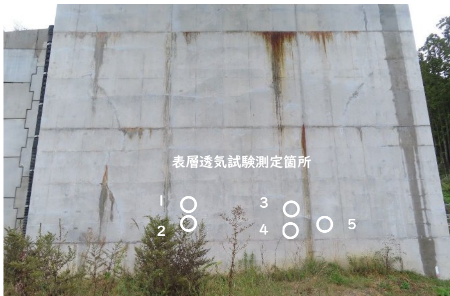
写真-2.5.2.22 表層透気試験の測定箇所
