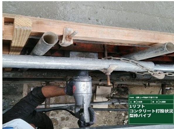
写真－2.5.2.37 型枠バイブレータ
