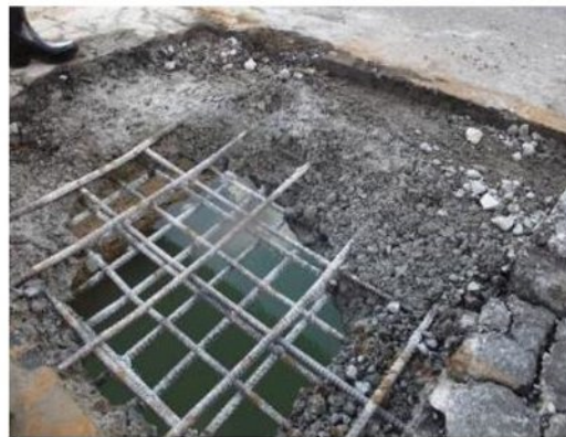
砂利化して抜け落ちた RC 床版
