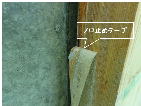
写真－2.5.2.34 ノロ止めテープ設置
