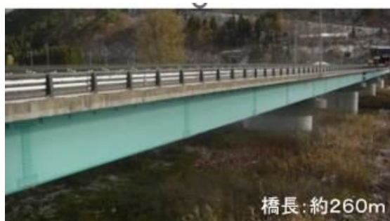
写真－2.4.1.12 砂利化で RC 床版の緊急打換えをした橋梁
