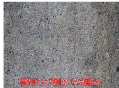
ひび割れ補修跡 (A2橋台)
