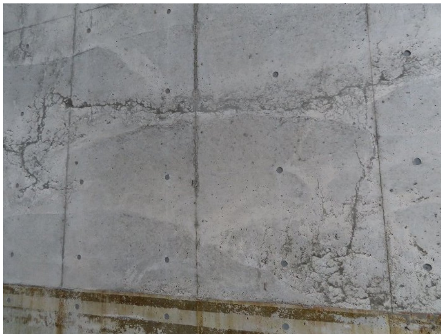
写真-2.5.2.13 面的な砂すじ（接写）
