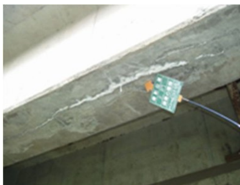
写真-2.5.1.6 主桁下面の充填不良の事例
