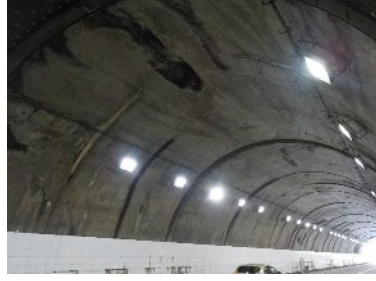
・ほとんどの目地で補修が実施されている。 ・導水板が設置されている箇所あり。
