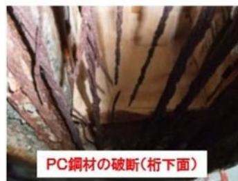
写真-2.5.1.4 桁内部の滞水により塩害を起こした例
