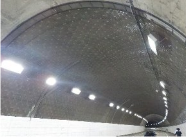
・全周にはく落防止ネットが設置されている。
