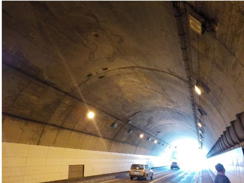
写真-2.5.4.3 1990年代の覆工例（補修・補強）
