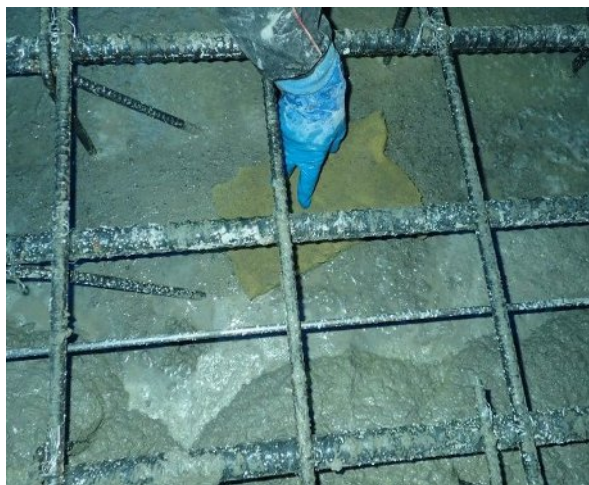
写真－2.5.2.32 ブリーディング水処理
