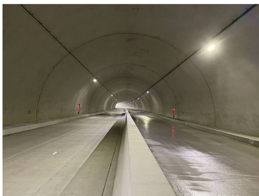
写真-2.5.4.17 覆工コンクリートの出来ばえ
