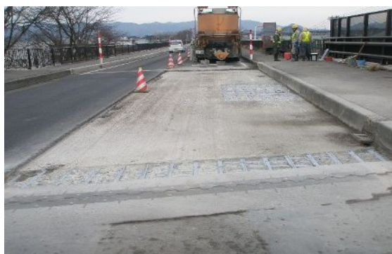
写真-2.4.1.10 橋面舗装の全面切削の例
