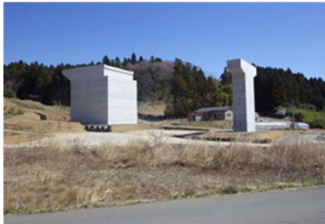
写真-3.3.1.1 K橋 A2橋台の全景図
