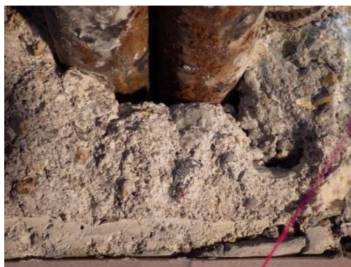
写真-2.5.1.6 主桁下面の充填不良の事例
