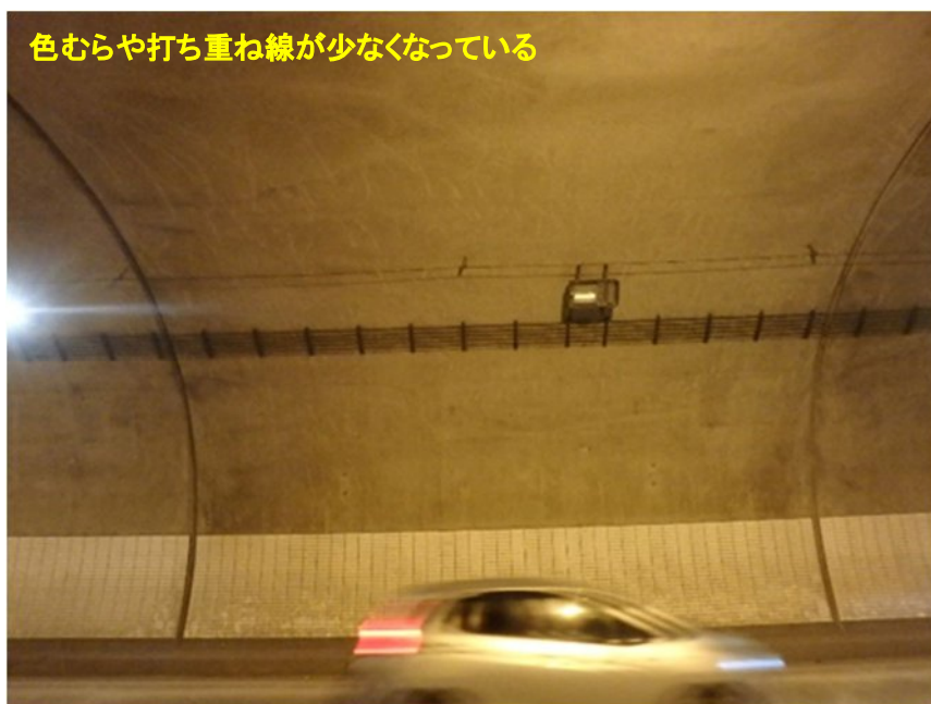
写真-2.5.4.8 2010年～2016年代の覆工の事例
