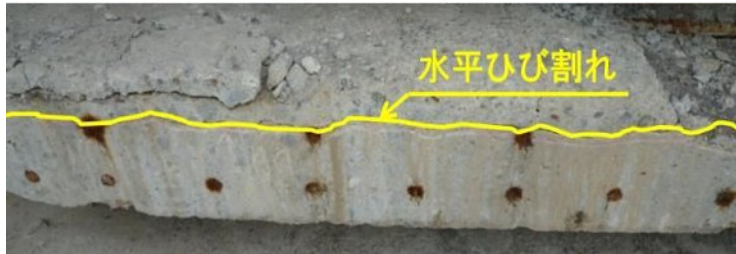
写真-2.4.1.14 RC 床版の水平ひび割れの上下における劣化状況の違い
