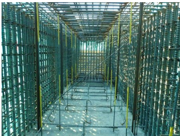
写真-2.5.2.30 巻出し厚のマーキング
