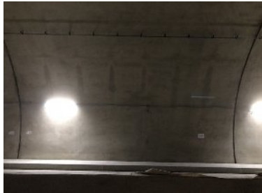
・【良好事例】検査窓間で浮きパイププレートによる締固めが実施されたと予想する。
