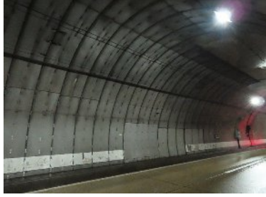
・全周に防護板が設置されている。
