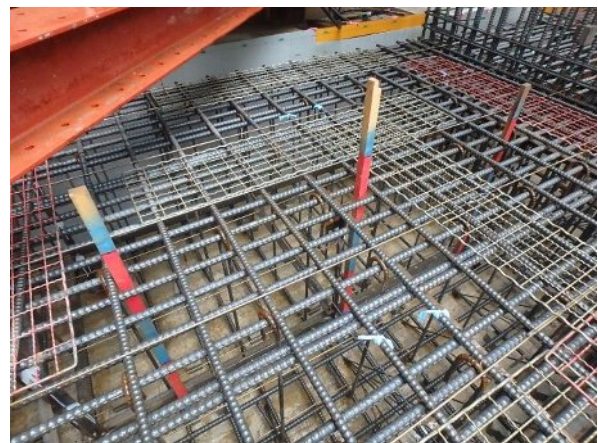
写真-2.5.2.31 打設高さ管理用定規
