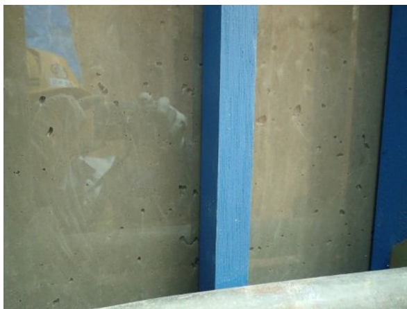
写真－2.5.2.38 透明型枠
