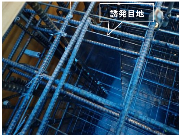
写真－2.5.2.40 ひび割れ誘発目地
