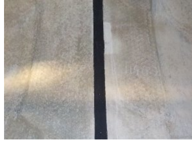
・天端部の補修跡。多くのスパンで実施されている。 ・天端吹き上げ口周辺にコールドジョイント。
