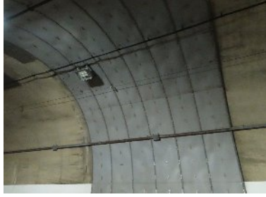
・全周に防護板が設置されている。
