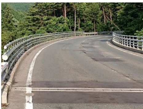
写真-2.4.1.2 走行軌跡上の連続した噴出物の事例
