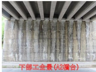
ひび割れ補修跡 (A2橋台)
