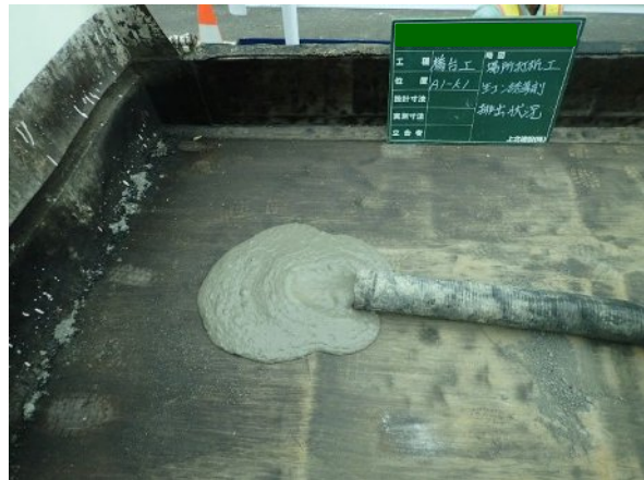
写真－2.5.2.26 コンクリート誘導剤排出
