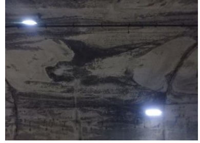
・天端は2箇所の吹き上げ口から打設している。
