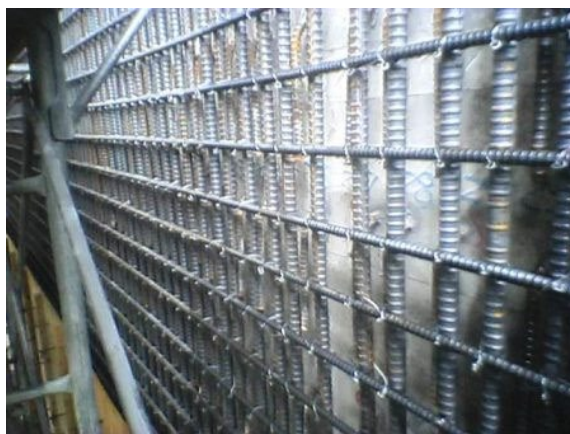
耐震補強工事の見学
