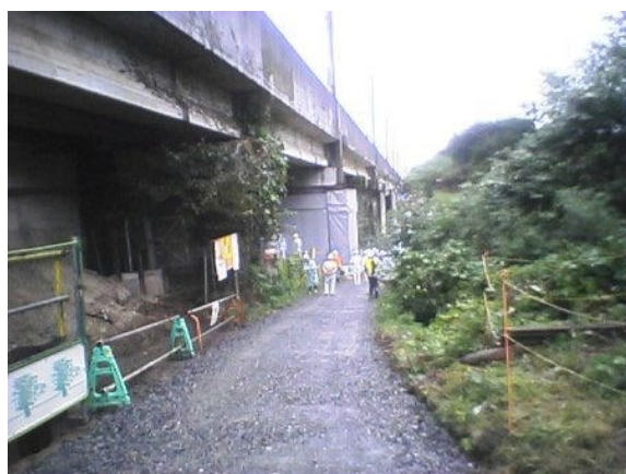
耐震補強工事の見学
